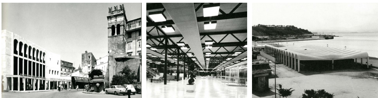
46. Εθνική Τράπεζα της Ελλάδος, 1968-69: επανεμφάνιση των παραδοσιακών τοξοστοιχιών στην όψη του καταστήματος 47. Αεροσταθμός Κερκύρας, 1966-70: άποψη του εσωτερικού, 48. Κτιριακό Συγκρότημα Λιμένα Κερκύρας, 1967-69: πανοραμική άποψη
