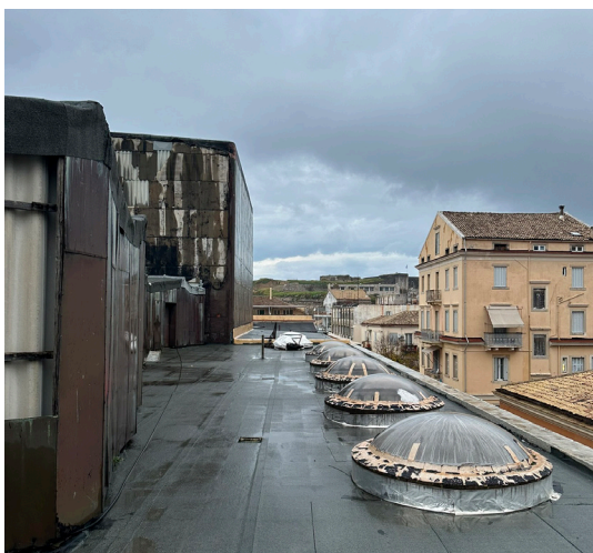
62, 63. Η απόληξη του όγκου της σκηνής και της κεντρικής αίθουσας του Θεάτρου καθώς και η οριζόντια επιφάνεια του δώματος χρίζουν καθολικής επισκευής
