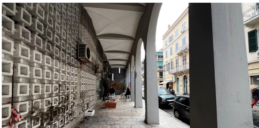
13, 14. Φθορά στα τσιμεντένια προκατασκευασμένα κλωστρά και κατάληψη από πτηνά στις εσοχές της οδού Ν. Μαντζάρου
