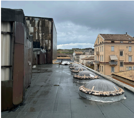
25, 26. Η απόληξη του όγκου της σκηνής και του της κεντρικής αίθουσας του Θεάτρου καθώς και η οριζόντια επιφάνεια του δώματος χρήζουν καθολικής επισκευής
