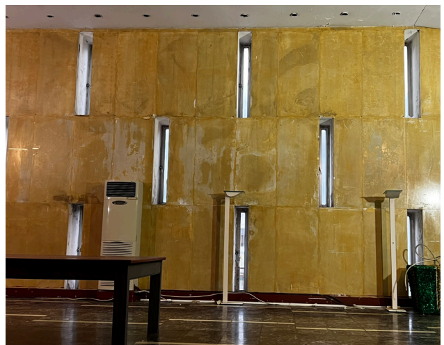
56, 57. Απόψεις του φουαγιέ όπου διακρίνεται το πρόχειρο χώρισμα της νότιας νεότερης μικρής αίθουσας (αριστερά) και η επιχρωματισμένη εσωτερική επιφάνεια του τοίχου της πρόσοψης με ορθομαρμάρωση (δεξιά)
