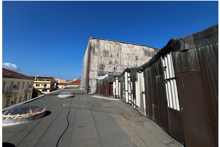
25, 26. Η απόληξη του όγκου της σκηνής και του της κεντρικής αίθουσας του Θεάτρου καθώς και η οριζόντια επιφάνεια του δώματος χρήζουν καθολικής επισκευής
