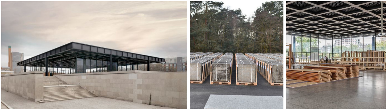
30. Εξωτερική άποψη του κτιρίου, 31. Χώρος ταξινόμησης τμημάτων των επενδύσεων, 32. Εικόνα από τη φάση των εργασιών
